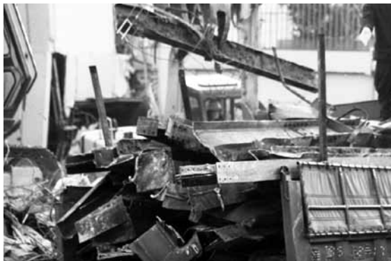
鉄骨に吹き付けられたクロシドライト
