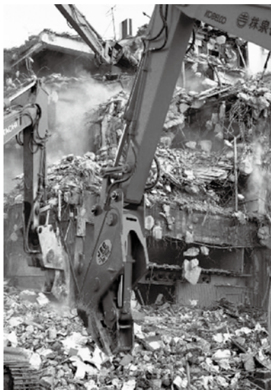
粉じんが舞う解体作業現場＝1995年2月、神戸市兵庫区（神戸新聞社提供）
