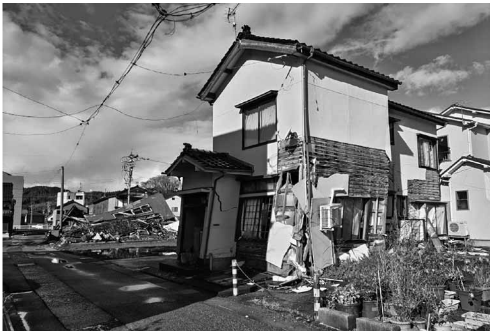
震災から 1 年近くたとうとしているが、崩れたままの家屋が目立つ石川県輪島市（2024 年 12 月）
