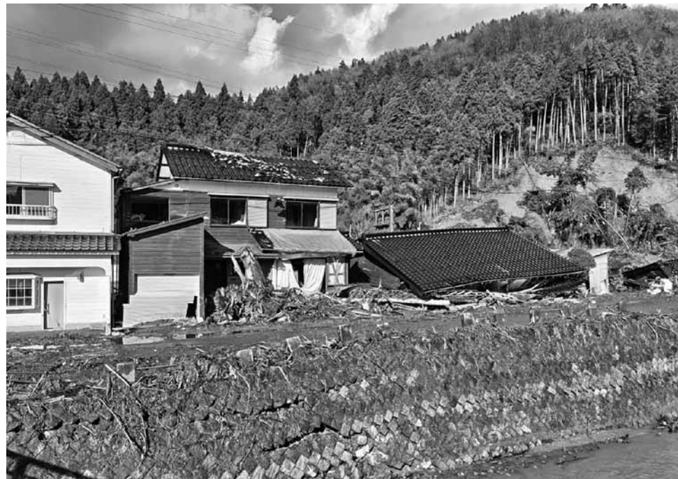
水害の影響を受けた石川県輪島市田野町（2024 年 12 月）
