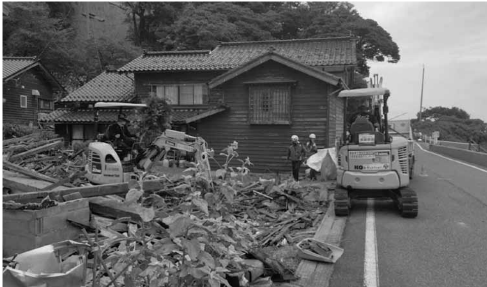
石川県珠洲市では民間ボランティアが家屋を解体（2024年8月）
