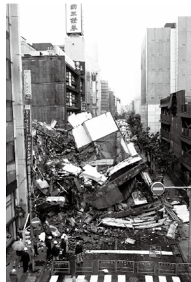
崩れ落ちた被災ビル＝1995年5月、神戸市中央区（神戸新聞社提供）
