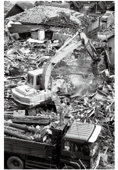
家屋の解体、処理が進む現場（神戸新聞社提供）
