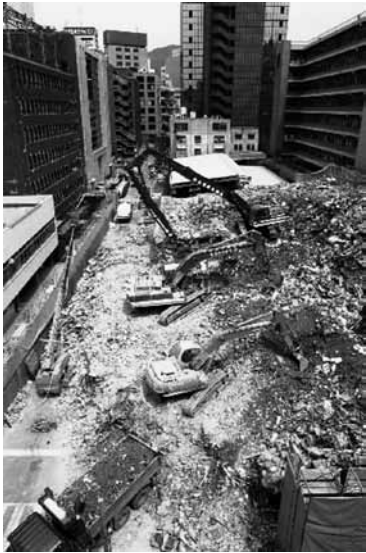
被災ビルを重機で解体＝1995年4月、神戸市中央区（神戸新聞社提供）
